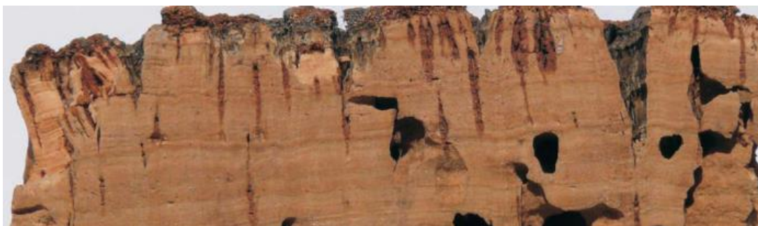
Rysunek 1.23 Galerie owadów spowodowane przez mrówki (zdjęcie z [58]).
