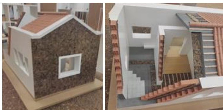
Rysunek 3.3 Izolacja domu wykonana z aglomeratu korkowego.
