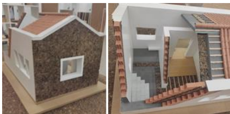
3.3 Pav. Kamštinio aglomerato namo izoliacija
